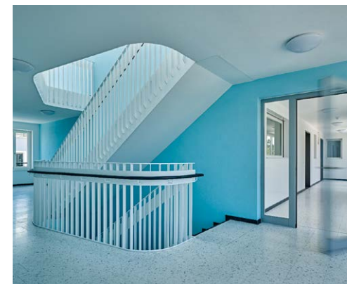
Die kühlere Farbgestaltung der Treppenhäuser mit der Premium-Silikatfarbe KEIM Innostar in Blau- und Türkistönen nimmt Bezug zum Eisspeicher, aus dem die meiste Energie für Heizung und Warmwasser gewonnen wird. © Keim
