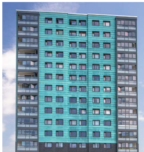
Das Wohnhochhaus Poppenrade 5 nach der energetischen Sanierung. © Solarlux GmbH, Fotograf Jan Haeselich
