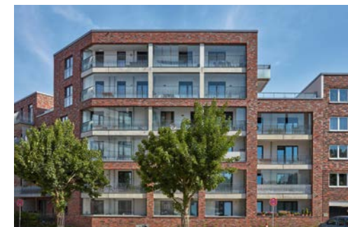
Herausforderung Schallschutz: Die raumhohe Balkonverglasung schirmt Lärm effektiv ab. © Solarlux GmbH, Fotograf Jan Haeselich
