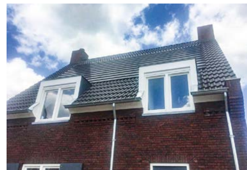
BU: S-Pfannen auf dem Dach: PV-Module ohne Sonderkonstruktionen auf dem Dach © Dachziegelwerke Nelskamp
