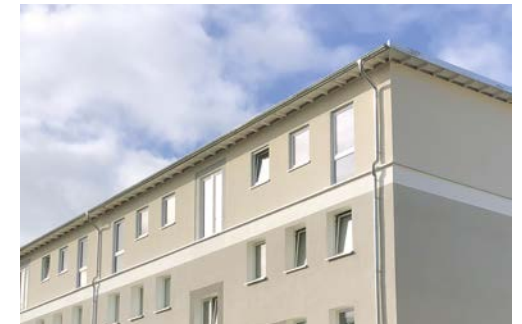
Dachaufstockung Mörikestraße 1-11, Essen © Fischbach
