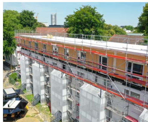
Dachaufstockung im Bau © Fischbach
