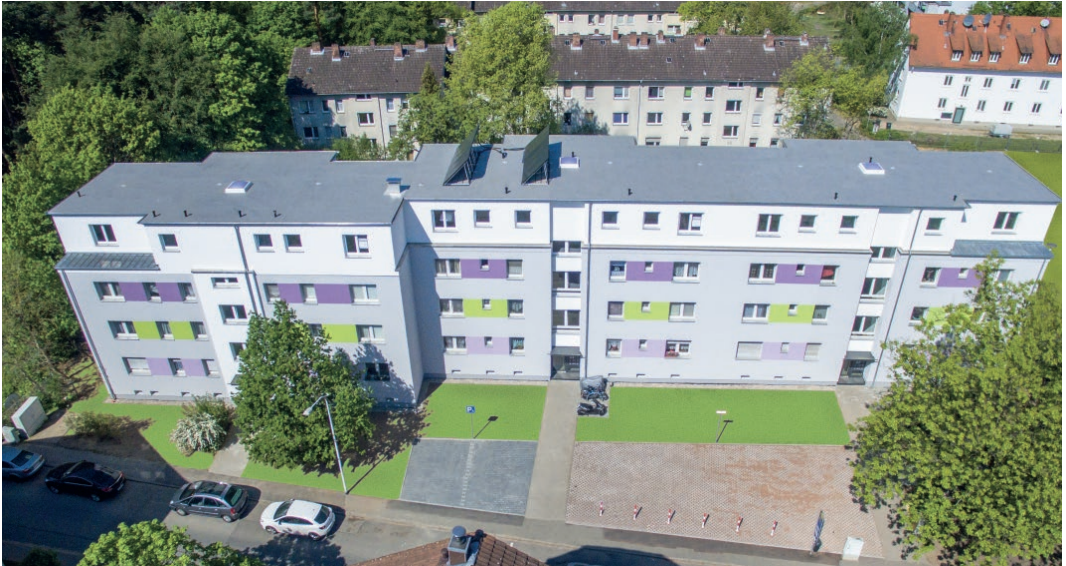
Binovabau-Dachaufstockung mit rund 450 qm 2 neuer Wohnfläche in Darmstadt
