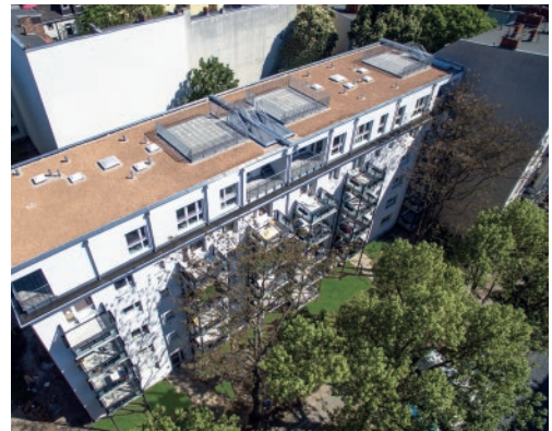
Dachaufstockung in Berlin mit 4 großzügigen Appartements
