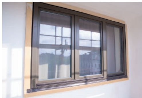
Fassadensanierung: Montage der Fenster in der Dämmebene
