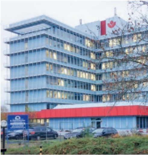
Verwaltungsgebäude Mainz: Installierte Kesselleistung: 1.860 kW Ermitteltes Einsparpotenzial: 23.000 € p.a. (30%):
