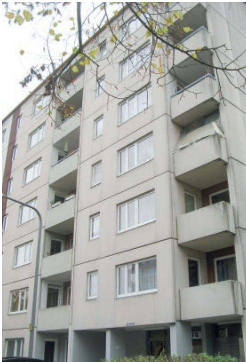
Mehrfamilienhaus Wiesbaden: Installierte Kesselleistung: 524 kW Ermitteltes Einsparpotenzial: 3.800 € p.a. (10%)
