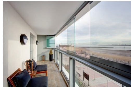
Die Schiebe-Elemente befinden sich auf einer Brüstung und lassen durch Teilöffnungen gezielte Temperatursteuerung zu.
