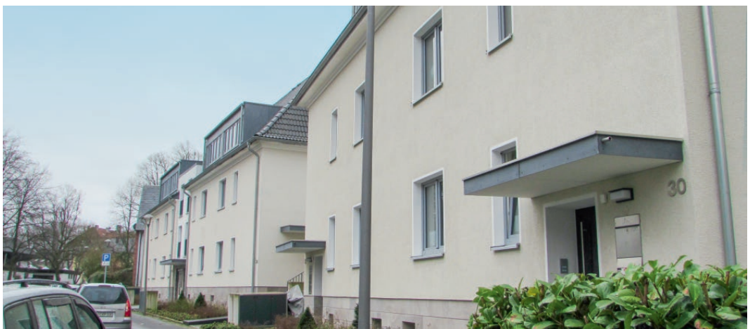
Sanierete Mehrfamilienhäuser „Witte Wie“ 30-32 und 34-40 in Bochum-Langendreer
