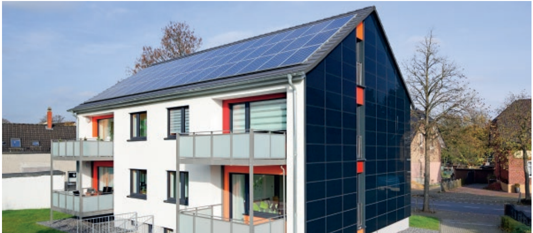
Mit einer modernen Photovoltaikanlage lassen sich Mehrfamilienhäuser sinnvoll aufwerten
