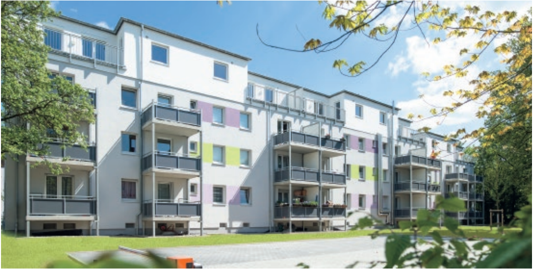
Darmstadt Stockhausenweg nach der Aufstockung
